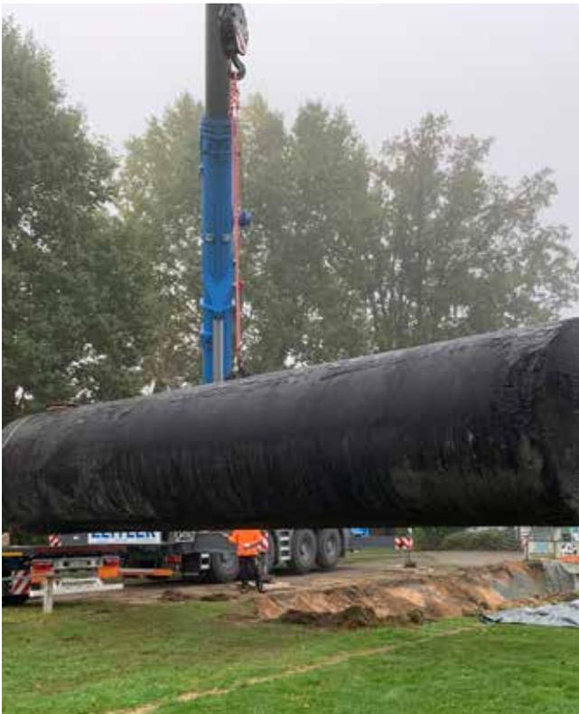
Das neue Bewässerungssystem beim TSC nimmt Konturen an. Nach dem Bau des Brunnens und dem Einbau der Beregner wurde heute die 60.000 Liter fassende Zisterne geliefert und per Kran in die dafür vorgesehene Baugrube gehievt. Demnächst wird die dazugehörige Pumpe installiert. Unser Dank geht an die freiwilligen Helfer!
